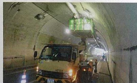
トンネルの点検診断
