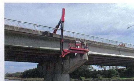
橋梁の点検診断
