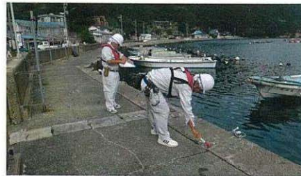
漁港施設診断(簡易調査)
