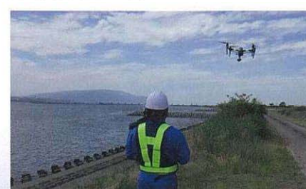
UAVによる3次元測量
