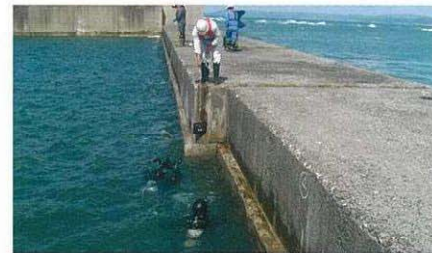
漁港施設診断(詳細調査)
