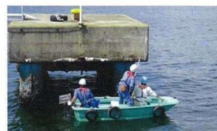
港湾・漁港施設の調査
